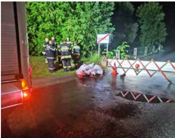
Mobiler Hochwasser-Schutz wurde bei der Feistritzbrücke von der FF Gersdorf eingesetzt.
