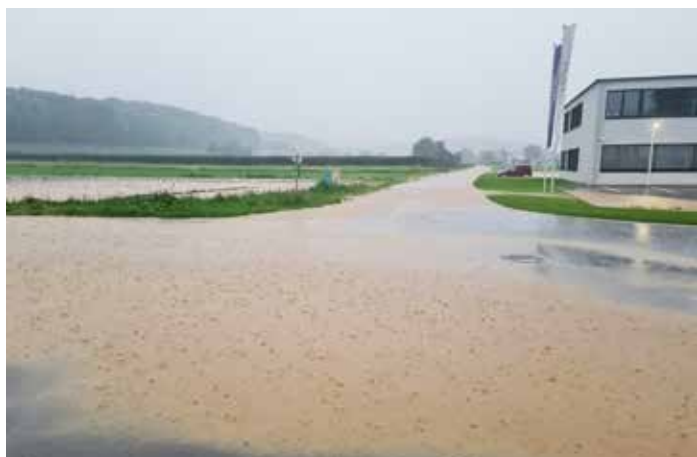
Dringender Handlungsbedarf ist am Trockenanlagenweg im Bereich der Fa. Grübl-Automatisierungstechnik gegeben.
