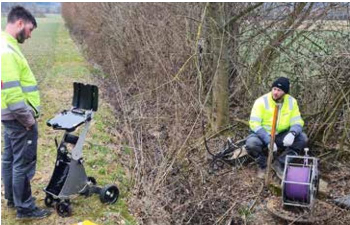
*Kanalzustandserhebung mittels Kamerabefahrung und örtlicher Erhebung mit Einmessung.*
