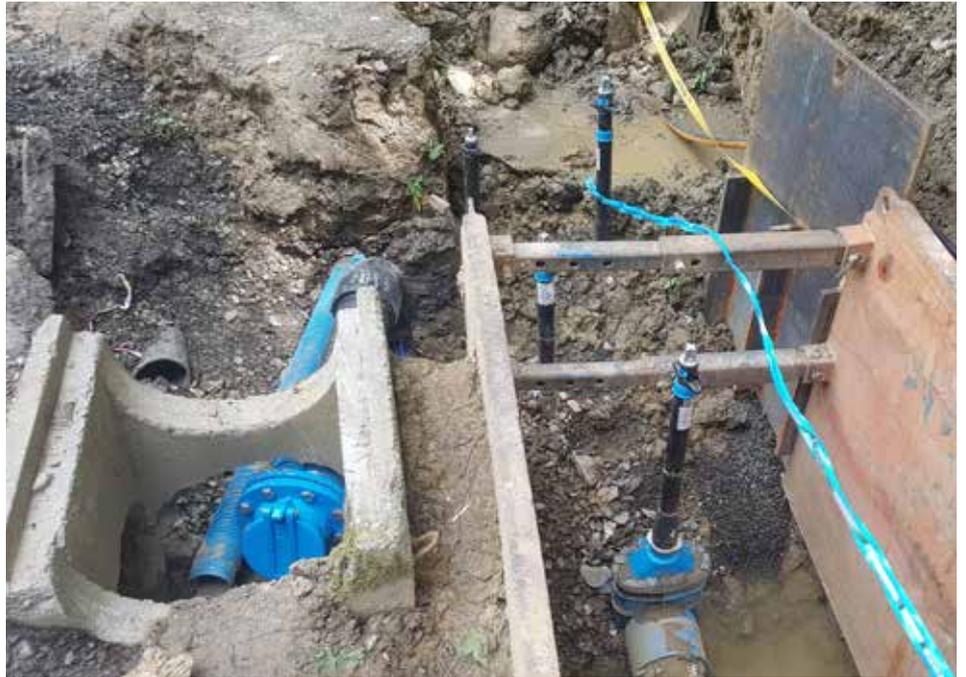
Bei der Verbindungsleitung wurden auch die Hydranten und sämtliche Wasserschieber erneuert.
